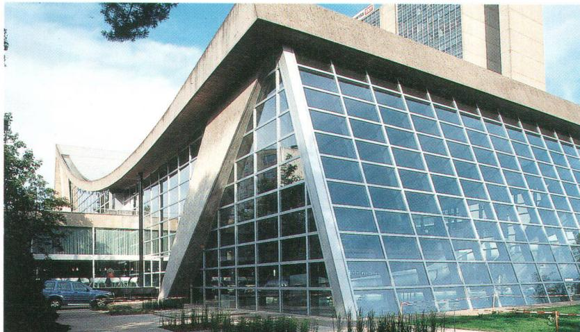
**Das grosse Schwebedach wird durch schräg gestellte Pfeiler hochgestemmt. Darunter wirken die weiten Glasflächen fein und leicht**
