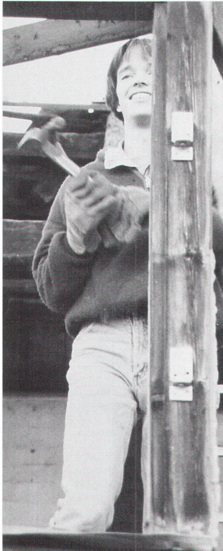
Nils Fretz legt selber Hand an bei der Sanierung seines Dachstuhls (Bild SHS)
