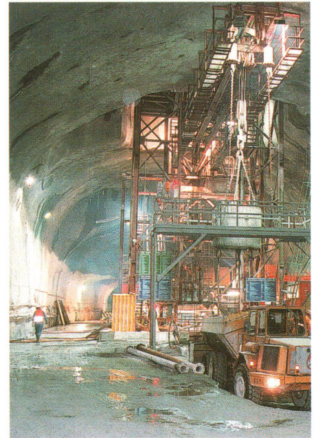
Grossbaustelle NEAT in Sedrun: Von der Schachtdopf-Taverne aus wird der Vertikalschacht des Zugriffsstollens erstellt
