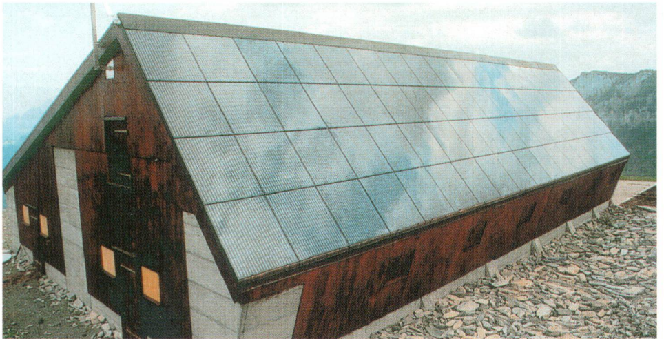
Die Einkleidung eines Daches mit Solarzellen wird bei der Alp Findels ob Pfäfers SG als eigenes gestalterisches Element wahrgenommen. (Bild TNC Consulting AG) La pose de cellules photovoltaïques sur le toit de l'alpage Findels au-dessus de Pfäfers SG est un élément architectural en soi (photo TNC consulting AG).
