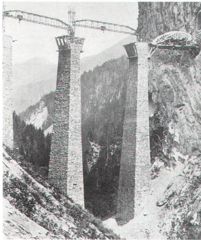
Der steinerne und 65 m über dem Talboden liegende Landwasserviadukt (1901/1902) ist die spektakulärste Brücke der Albulalinie. (Bild Rhätische Bahn) Le viaduc en maçonnerie (1901/1902) qui enjambe la Landwasser à 65 m de hauteur est l'un des ouvrages les plus spectaculaires de la ligne de l'Albula (photo chemins de fer rhétiques).
