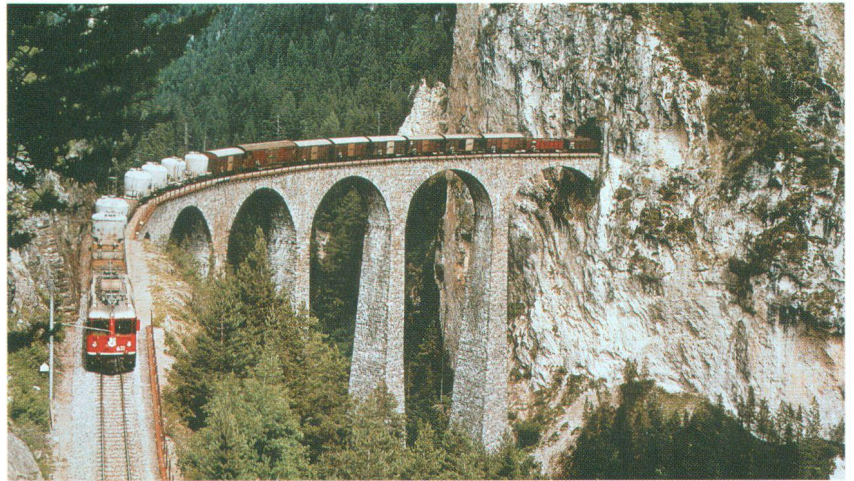
Der steinerne und 65 m über dem Talboden liegende Landwasserviadukt (1901/1902) ist die spektakulärste Brücke der Albulalinie. (Bild Rhätische Bahn) Le viaduc en maçonnerie (1901/1902) qui enjambe la Landwasser à 65 m de hauteur est l'un des ouvrages les plus spectaculaires de la ligne de l'Albula (photo chemins de fer rhétiques).
