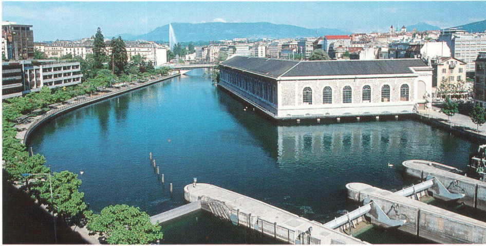
Le projet « Le fil du Rhône » rend à la promenade les abords du fleuve entre le lac Léman et le barrage du Seujet (photo Stähli).
