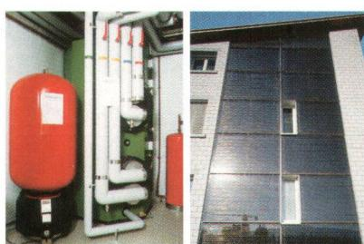
*Installations techniques durables, de haut en bas: bois de chauffage, pompe à chaleur avec chaudière à gaz, capteur pour chauffer l'eau (photos Führer, Schindler, Kopp). Nachhaltige Haustechnik, v.o.n.u.: Holz zum Heizen, Wärmepumpe mit Gaskessel, Fassadenkollektor für Warmwasseraufbereitung. (Bilder Führer, Schindler, Kopp)*
