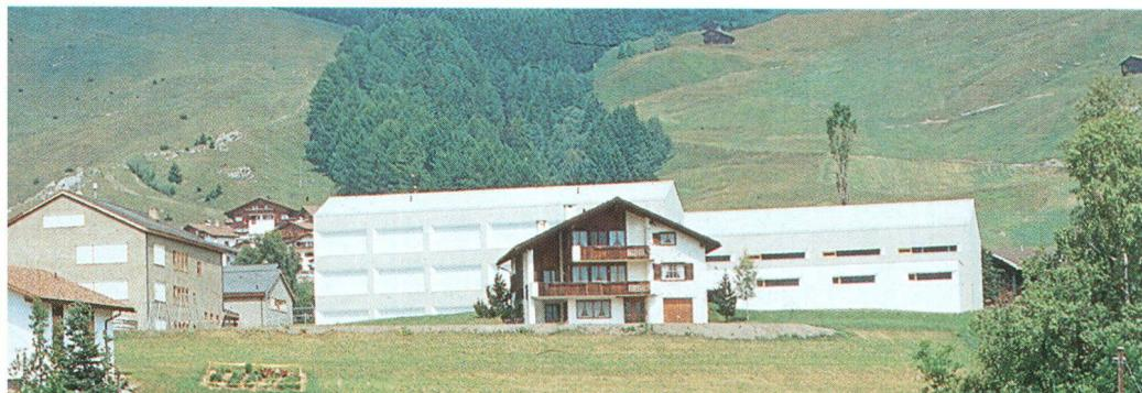
Mit dem 1998 eingeweihten Erweiterungsbau des Schulhauses Vella GR hat das Churer Architekturbüro Bearth&Deplazes einen wichtigen Beitrag zur architektonischen Umsetzung passiver Sonnenenergienutzung geleistet. Das Gebäude speichert Solarenergie in massiven Bauteilen und kommt ohne Heizung und Sonnenkollektoren aus. Das Gespräch führte Christoph Schläppi.
