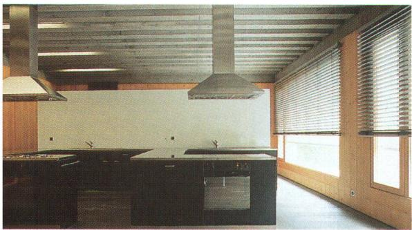
Die Küchendecke dient als Wärmeabsorber, Blendschutz für die Leuchten und die Schallabsorption. Die u-förmig eingefädelten Lamellen werfen das Licht an die Decke, die Rollen reflektieren im Sommer die Wärmestrahlung. (Bild Schläppi)
