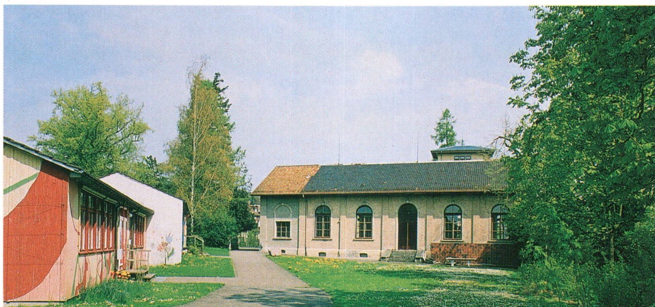
La première halle de gymnastique à Zurich doit être transformée et agrandie. Des négociations informelles entre le canton et la section cantonale de la LSP ont apporté quelques petits retards, mais le projet s'en trouve considérablement amélioré (photo Gattiker/LSP).
