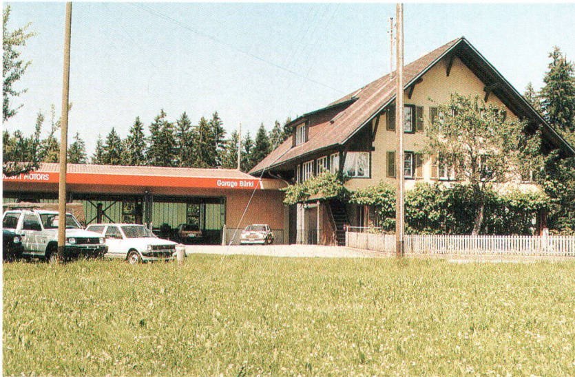
La révision de la LAT aggraverait le problème du changement d'affectation de bâtiments dignes de protection situés hors de la zone à bâtir (photo FSPAP). Mit der RPG-Revision würde auch der problematischen Umnutzung schützenswerter Landschaftsbauten jenseits der Bauzonen Vorschub geleistet. (Bild SL)
