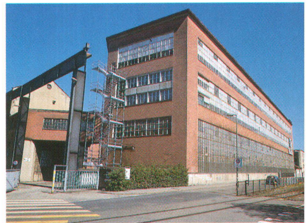
La halle dite «keep-cool», considérée comme un témoignage de l'ère industrielle, a été placée sous protection. (photo Hartmann)
