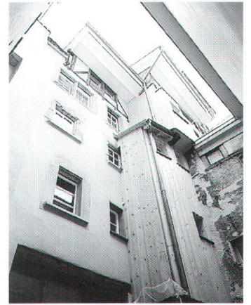
Das Haus Rindermarkt 7 nach der Erneuerung.
