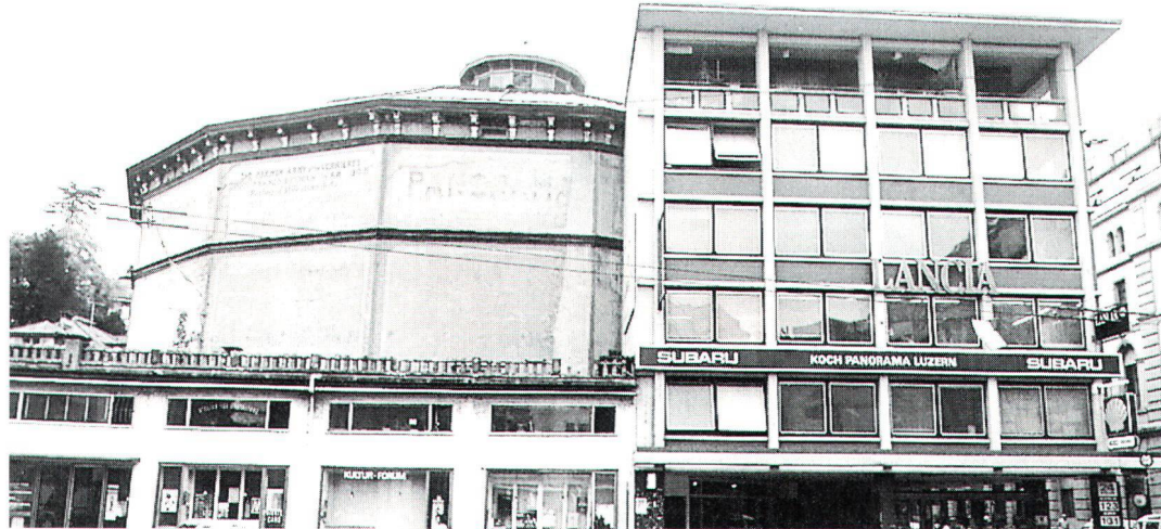
Die Restauratoren befürchten, dass die Malereien des Panoramas durch den Abbruch des fünf-geschossigen Betonbaues (rechts) beschädigt werden könnten.
