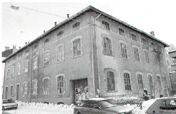
Vue extérieure et intérieure de l'ex-fabrique de chocolat Klaus, qui va être aménagée à l'intention de petites entreprises techniques et d'organismes d'expositions.
