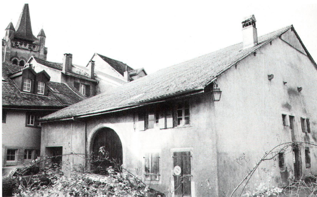
La ferme du XVII e siècle menacée de démolition, vue du nord-est (photo Zwahlen). Das abbruchgefährdete Bauernhaus aus dem 17. Jahrhundert von Nordosten gesehen. (Bilder Zwahlen)
