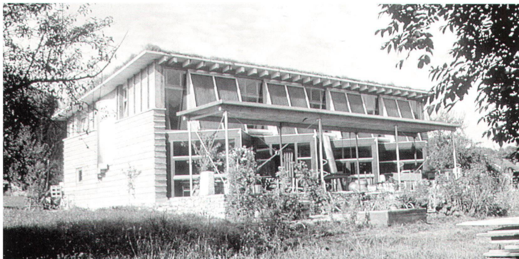
Beim Atelier Rauch in Schlins wurden die neuen Materialien und Fassadenelemente (Lehm/Solarzellen) nicht einer traditionellen Bauweise übergestülpt, sondern führten mit Stahl, Beton, Glas und Holz zu einem formal überzeugenden Ausdruck. (Bild Rauch)
