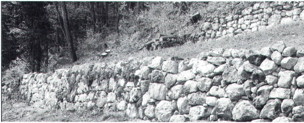
Die Rebbergmauern bei La Neuveville werden ohne Mörtel und nur mit behauenen Jurakalksteinen gefertigt und bilden wertvolle Nischenbiotope für eine artenreiche Fauna und Flora. (Bild FLS)
