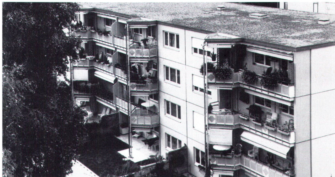
Bei diesem Blockbau wurden die Balkone vergrössert und im Erdgeschoss Privatgärten mit Sitzplätzen geschaffen (Bild Strähl).
