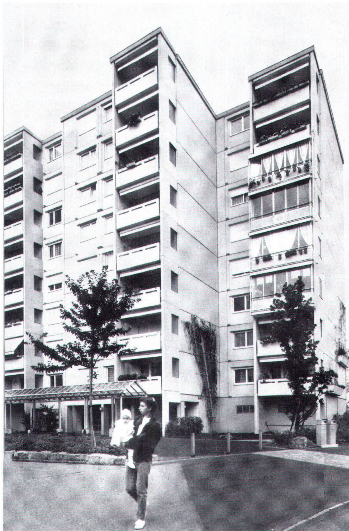
Quiconque le désirait a pu transformer son balcon en véranda. Wer wollte, konnte seinen Balkon in einen Wintergarten verwandeln lassen (Bild Stähli)
