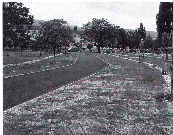
Sur un fond de pierres concassées qui se prête à l'infiltration, la végétation peut se développer aisément.
