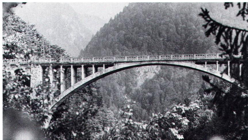
*Le pont des Planches, encore en son état original, avec ses intéressants enrobages de béton armé (photo Mandelmann).*
