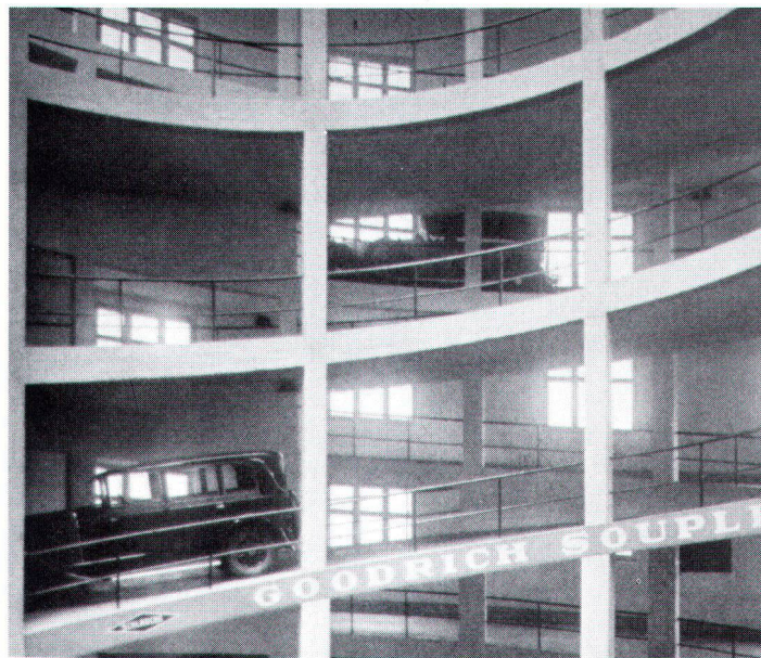
Rampenturm der Grossgarage Schlotterbeck (Bild SBZ).
