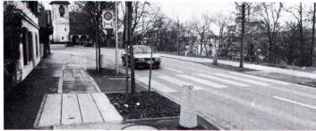
Redimensionierte Sinserstrasse mit Verengung bei Fussgängerstreifen (Bild Borner).
