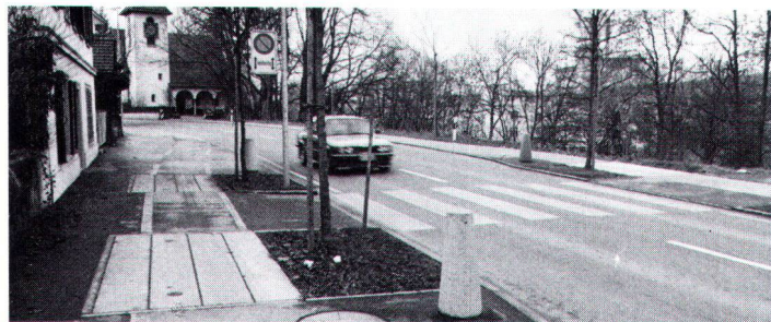
Redimensionierte Sinsstrasse mit Verengung bei Fussgängerstreifen (Bild Borner).
