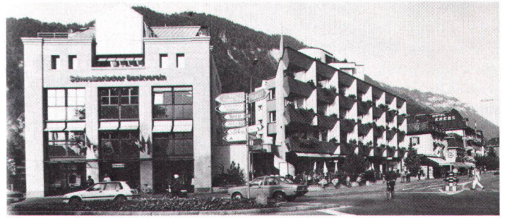
Von der Regionalgruppe ausgezeichnete Bankneubau in Interlaken mit der Würdigung «zeitgemässe Lösung mit städtischem Gepräge und hoher architektonischer Qualität» (Bild Benninger). Cette nouvelle banque d'Interlaken a reçu une distinction du «Heimatschutz» oberlandais, qui loue cette «solution moderne, de caractère urbain et d'excellente qualité architecturale».
