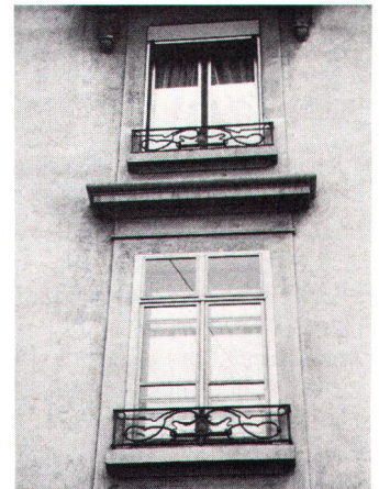
Des fenêtres doublées permettent notamment de conserver les anciennes. Vorfenster erlauben es unter anderem, die alten Fenster zu erhalten (Bild Oettli).
