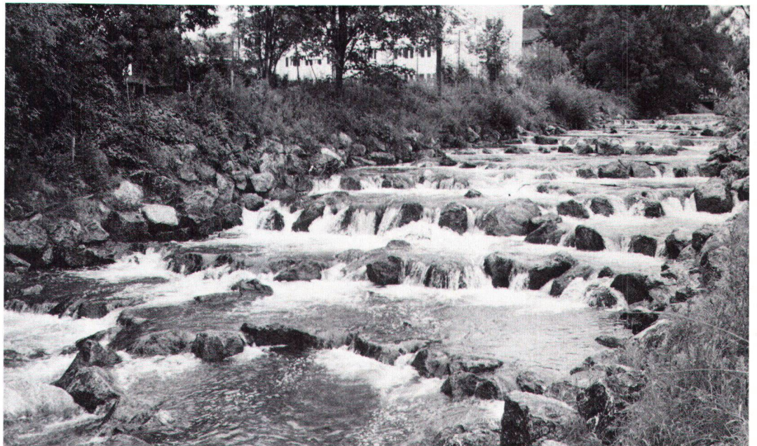
En ville aussi, de fortes chutes peuvent être maîtrisées avec des pierres naturelles. Grosse Abstürze lassen sich auch in der Stadt rückbauen (Bild Keller).
