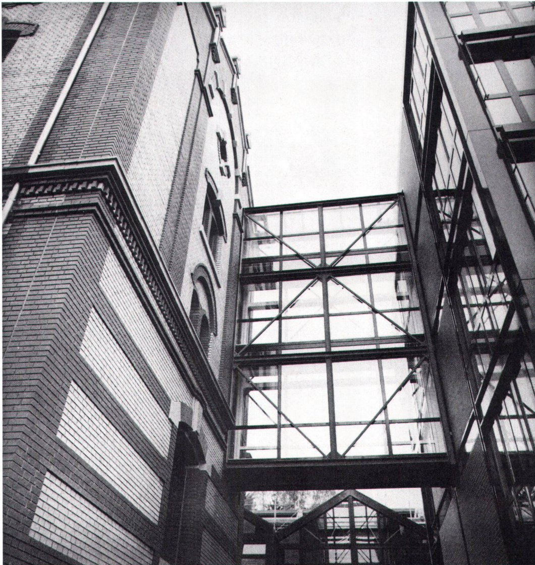
Verbindungstrakt zwischen Alt- und Neubau in der Mühle Tiefenbrunnen (Bild Mühlerama). Jonction entre un ancien et un nouveau bâtiment du moulin de Tiefenbrunnen.
