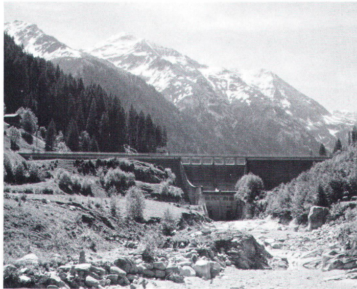
Débit restant: zéro (val Sumvitg GR) – est-ce cela l'ultime but visé pour d'autres rivières et ruisseaux?
