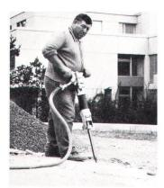
Kampf dem Maschinenlärm: Oben ein Abbauhammer ohne, unten einer mit eingebautem Schalldämpfer (Bild Stadtpolizei Zürich).
