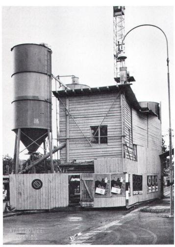
Gewerbliche und industrielle Anlagen, die Lärm erzeugen, müssen beispielsweise verschalt werden (Bild Stadtpolizei Zürich). Les installations artisanales et industrielles bruyantes doivent par exemple être munies d'un coffrage.
