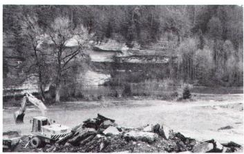
Retraitement de matériaux de construction en zone protégée. Bauschuttaufbereitung in geschützter Zone (Bild Morisod)
