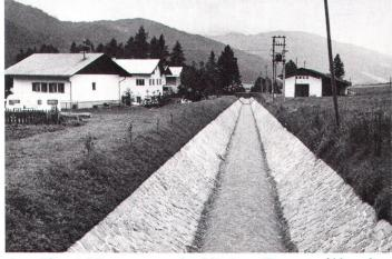
Arme Natur! Mit starrem, undurchlässigem Trapezprofil kanalisierter Bach (Bild Weiss)
