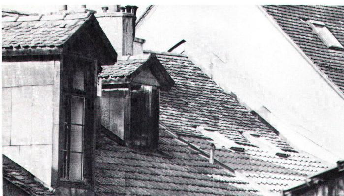
lucarnes (tuiles à recouvrement) ou même sur des éléments verticaux (tuiles clouées).
