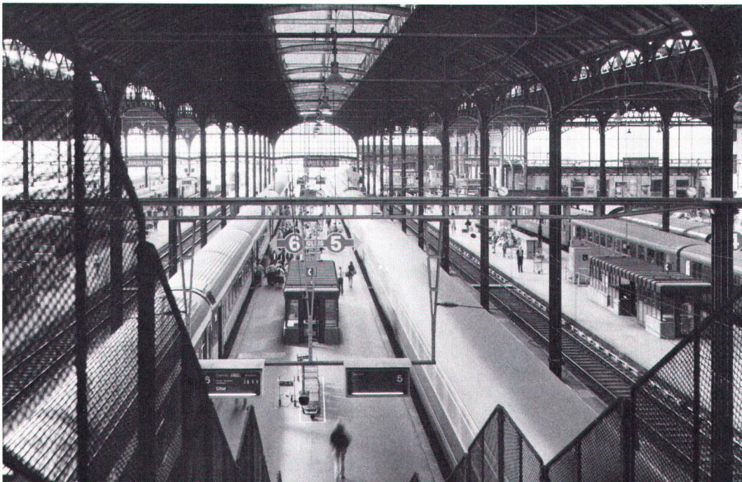
Blick in die Basler Bahnhofhalle mit den geschützten Perrondächern (Foto Bernauer). Coup d'œil dans la halle de la gare de Bâle, avec les toitures (protégées) des quais.
