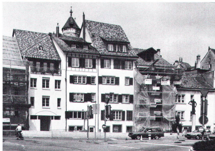
Kontinuierliche Pflege schont Haus, Geldbeutel und Ortsbild (im Bild Schaffhauser Altstadt, Foto Stähli)
