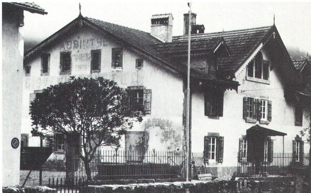
Zeuge einer legendären Ära (Bild Stähli). Témoins d'une époque.
