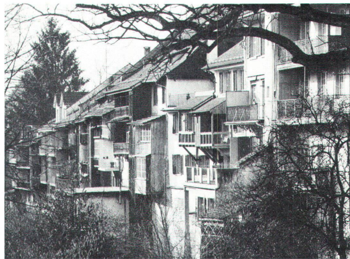
Blick hinter die Altstadtkulisse. Un coin de la vieille ville vue de derrière.
