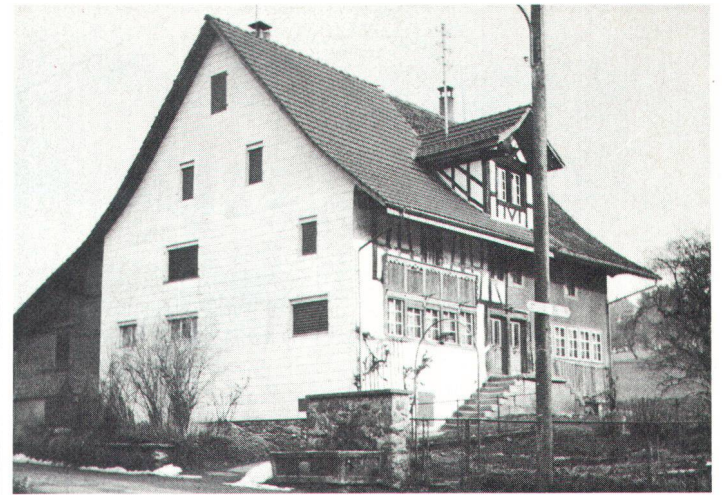
Wetterschutz für ein schönes Bauernhaus – vielleicht zweckmässig, doch hässlicher könnte es kaum sein (Bild Hauser).
