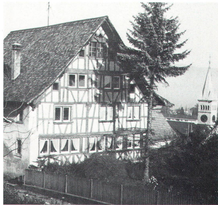
Oben: Riegelhaus vor der Renovation mit sprossenlosen Fenstern. Das wirkt blind. Unten: nach der Renovation mit Sprossenfenstern. Das Haus «sieht» wieder (Bilder Friedli).
