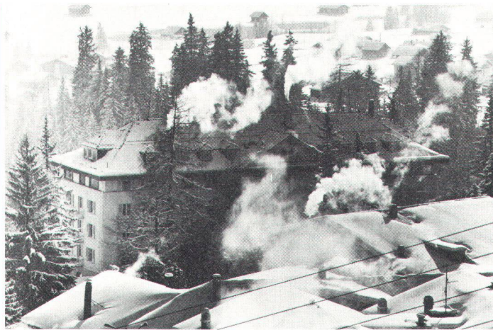
Luftverunreiniger Nr. 3: unsere Heizungen (Bild Stähli). Polluant n° 3 de notre atmosphère: les chauffages.
