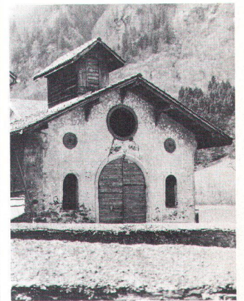
Durch den Heimatschutz gerettet: Das Spritzenhaus im Dornhaus Diesbach vor (oben) und nach (unten) der Restaurierung (Bilder Aebli)
