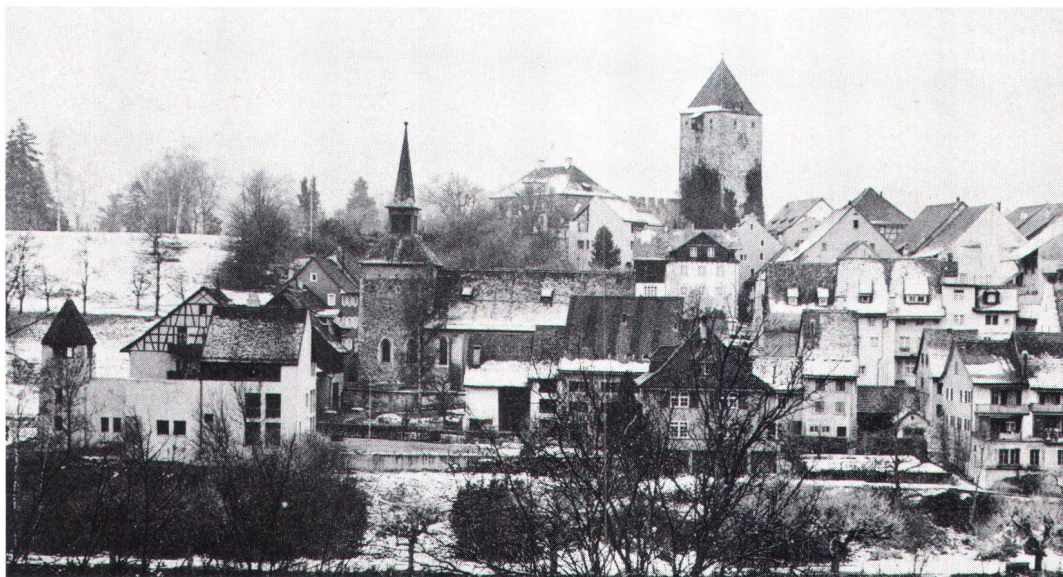
Besonders sorgfältig sind Neubauten in historische Städtchen einzuordnen, wie hier in Kaiserstuhl (Bild Stähli)
