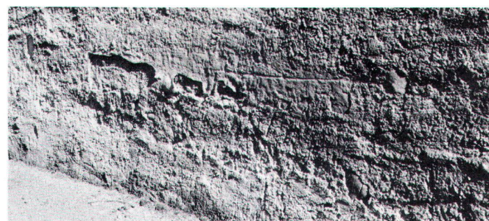
Malgré un décollement partiel dû à un ruissellement, ce crépi à la chaux traditionnel a bien résisté (photo Baertschi).
