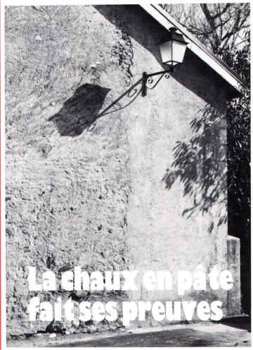
Bien qu'usé par le temps, le crépi à la chaux a conservé un mouvement et une structure intéressants (partie de gauche). A droite, crépi au ciment surajouté (photo Baertschi).
