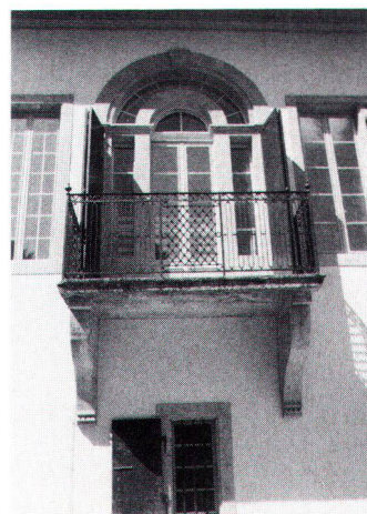
Fenêtre serlienne (du nom de l'architecte Serlio 1475–1554) de la façade est du manoir de Champ-Pittet (photo Bodinier).
