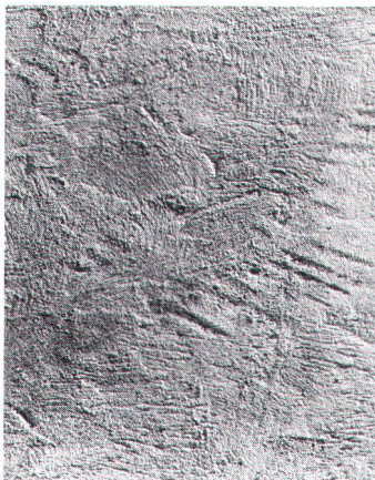
Crépi à la chaux portant à l'évidence la «signature» du maçon (photo Baertschi).
