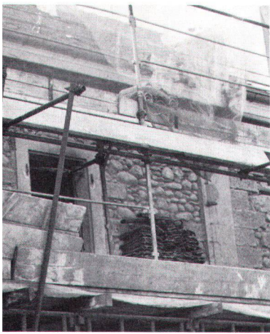
Piquage d'une façade faisant apparaître des boulets de rivière liés à la chaux (photo Baertschi).
