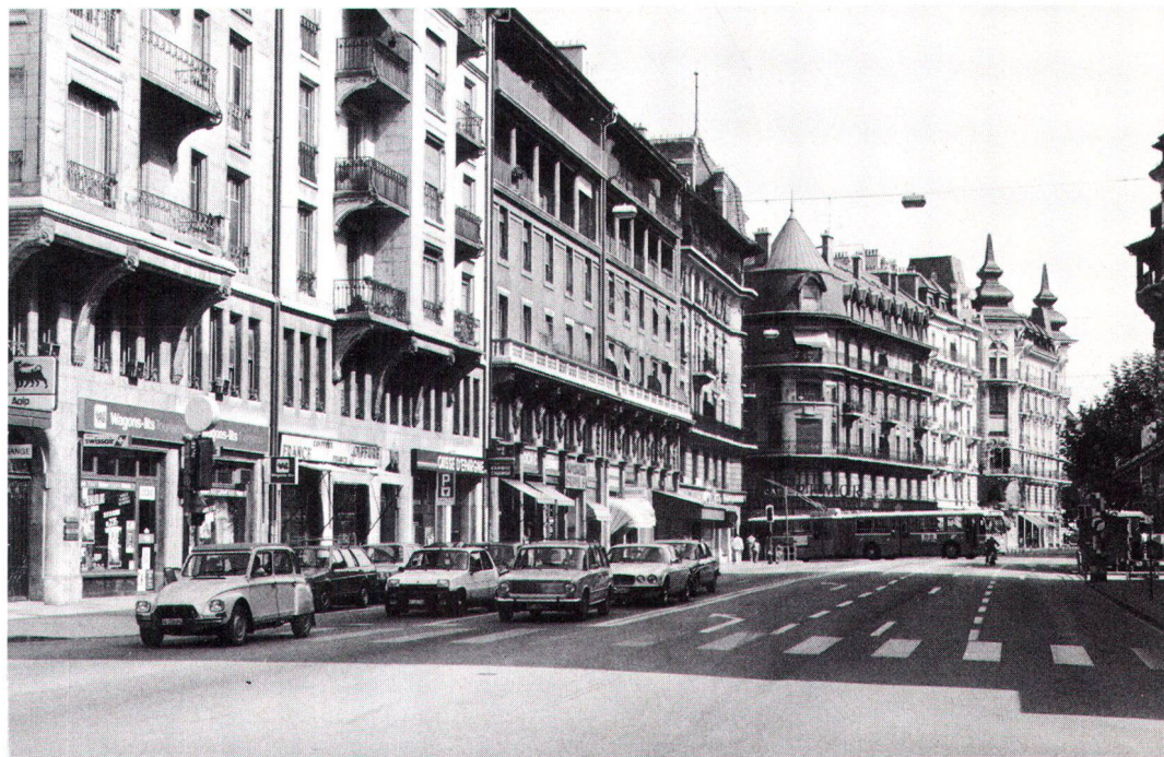
Au quartier des Eaux-Vives, on peut suivre l'évolution architecturale de la seconde moitié du XIX e siècle (photo ISOS)
