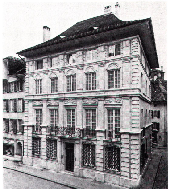
Bauberatung will nicht nur historische Bauten erhalten... (Archivbild: Solothurn)
