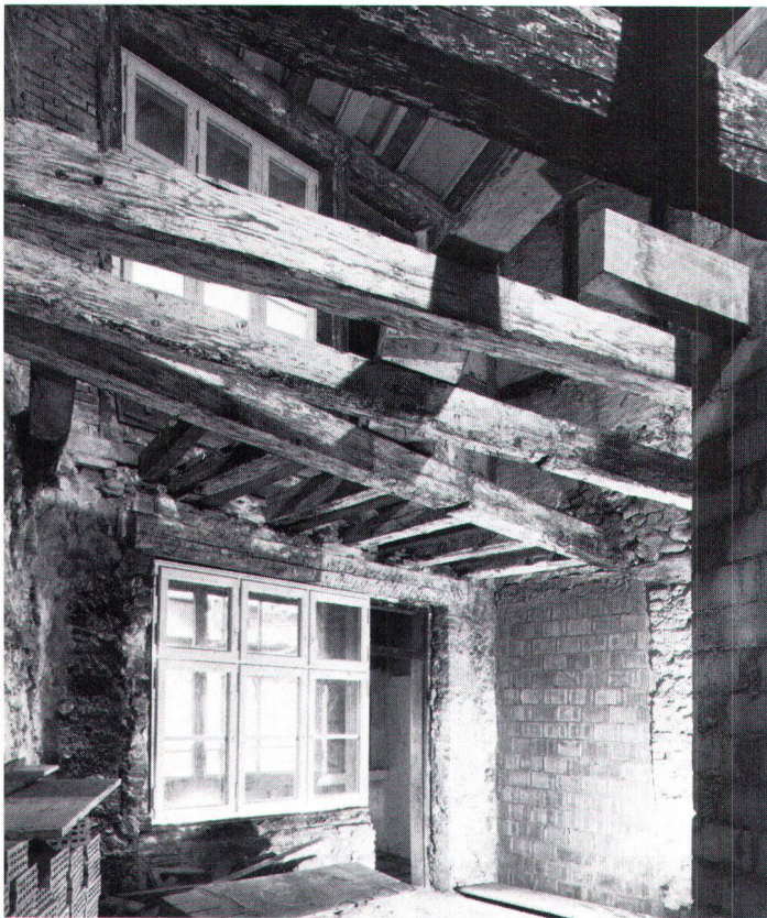
In Altbauten sollten die ursprünglichen Holzbalkendecken wenn immer möglich erhalten werden – aus optischen und statischen Gründen (Bild Hochbauamt Stadt Basel)
