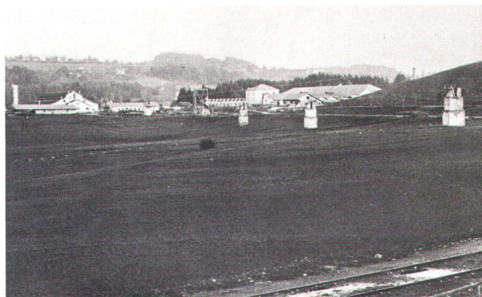
Péroles FR vers 1875, avec transmission téléodynamique de l'énergie hydraulique (photo A. P. I.).
