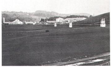
Pérolles FR vers 1875, avec transmission télédynamique de l'énergie hyraulique (photo A. P. I.). Pérolles FR um 1875 mit Energieübertragungsanlage
