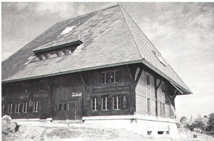
Wiederaufgebautes Hochstudhaus in Rüti/Lyssach. Das Haus geriet an seinem ursprünglichen Ort immer mehr in die Nähe von Wohnblöcken und wurde zum Fremdkörper (Bild Mäder).
