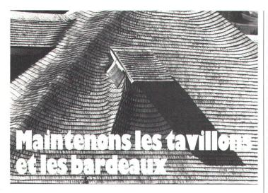
Les bardeaux, appelés également «ancelles», sont des planchettes d'une épaisseur d'environ 1 cm mesurant environ 60 cm par 20 cm. Ils sont plutôt posés sur des toitures à faible pente, alors que les tavillons (environ 40 par 10 ou 20 cm et 3 à 5 mm d'épaisseur) couvrent généralement des toits à pentes plus importantes. Les tavillons et surtout les clavins (de dimensions encore plus petites et à la découpe arrondie) sont utilisés également pour les revêtements de façades.
