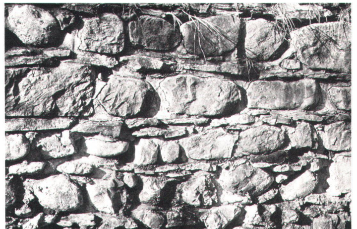
Eine Studie will die Dauerhaftigkeit des bei alten Burgenrestaurierungen verwendeten Mörtels untersuchen (Bild ETH Zürich).
