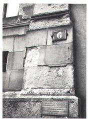
Luftverschmutzung und Bodenerschütterungen machen immer häufiger Fassadenrenovationen notwendig (Archivbild SHS). La pollution de l'air et les vibrations du sol rendent de plus en plus souvent nécessaires les rénovations de façades.
