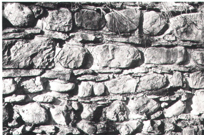
Eine Studie will die Dauerhaftigkeit des bei alten Burgenrestaurierungen verwendeten Mörtels untersuchen (Bild ETH Zürich).
